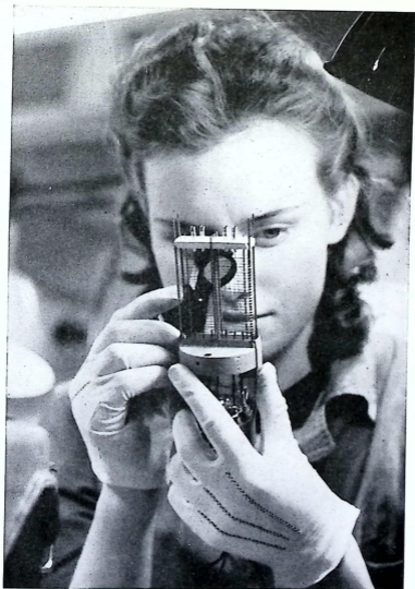
Bild 22. Det inre av ett medelstort sändarerör (PB 3/800) under montering. På bilden synes att glödtråden är upphängd i spiralfjädrar, så att den förblir spänd även då den genom värmen utvidgat sig. Första gallret är monterat men skymmes av skärmgallret, vars maskor tydligt kan urskiljas, liksom den nedre skärmplåten, vilken är förbunden med skärmgallret. (Philips).
