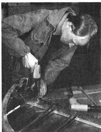
Plåtavdelningen - reparation av sidoroder.
