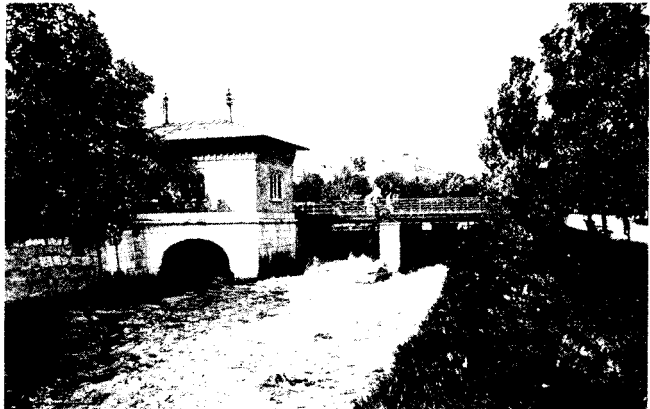
Turbinhuset, Västerås stads kraftstation i Svartån, är det enda bevarade byggnadsminnet från ASEAs tidigaste år i Västerås.
