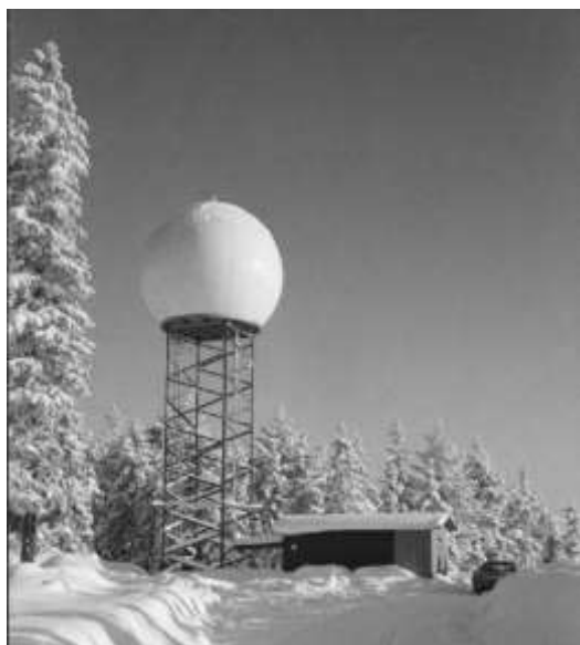
Typiskt utseende av Väderradar PV883, bild från Hudiksvall. Foto, Sten Wiklander MTVH
