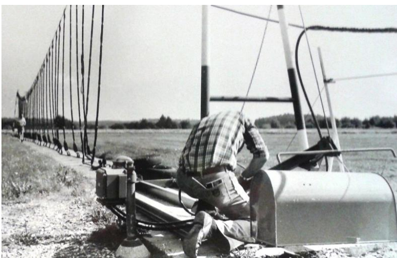
Arbete på utrullningshindret bana 19, F1.
