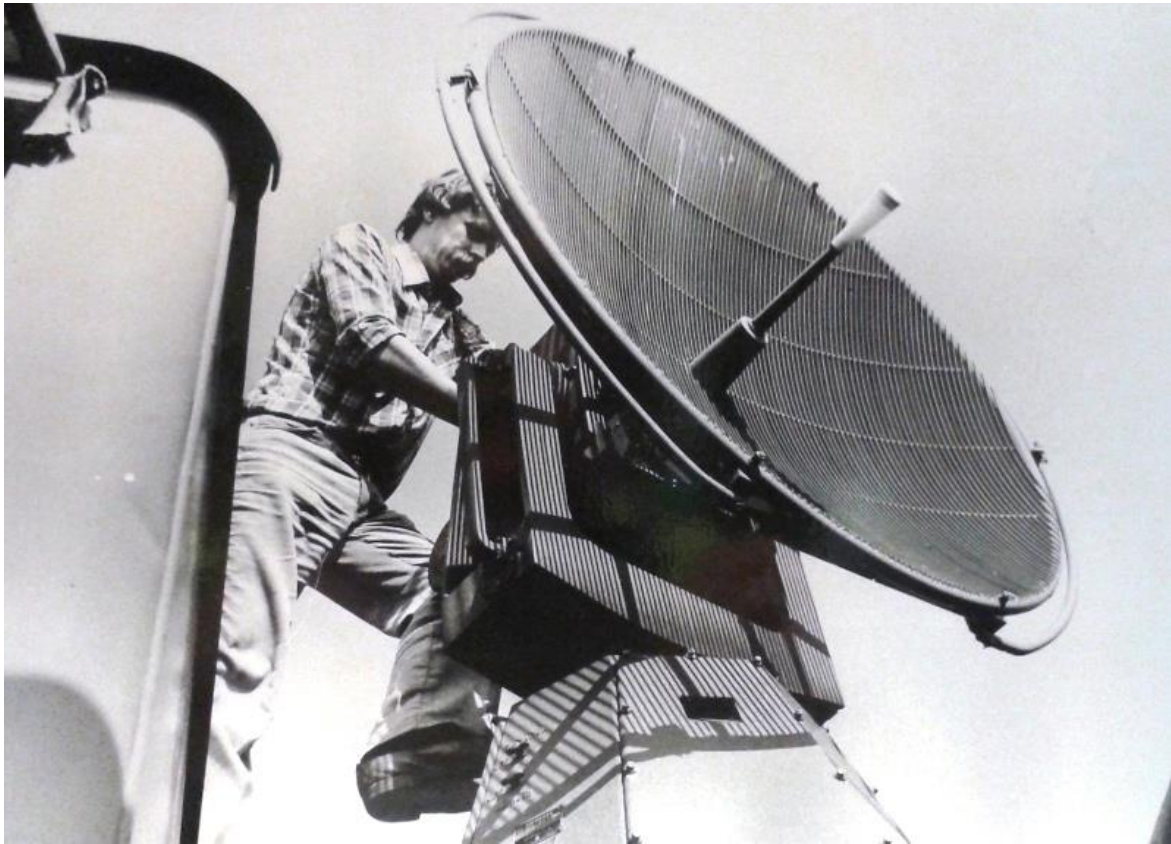
Service på antenn, PV30
